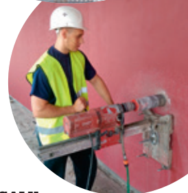
SALU TILTA 2. kārtas pārbūves projektēšana. Salu tilta speciālā inspekcija. Betona parauga urbšana Salu tiltam.
