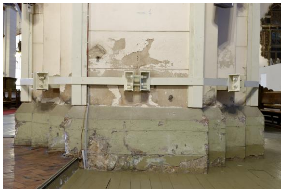
1.att. Kolonnas austrumu puse pirms restaurācijas/ The east side of column before restoration
