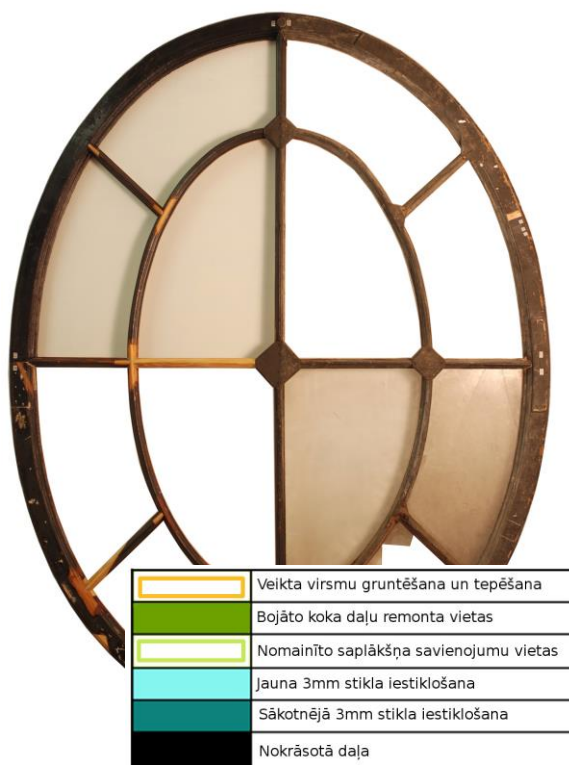
3.att. Loga rāmja iekšpuse pēc restaurācijas/ Inside of the window frame after restoration
