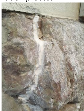
4.att. Plaisas ar injekcijas materiālu / Gap with injection material
