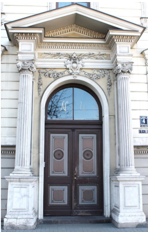
4.att. Grezns K. Valdemāra ielas ieejas portāls ar apaļkolonnām, ziedu virtenēm, laužtas dzegas frontonu.
