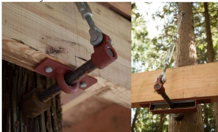
1.3.4 attēls. Sijas balstu elements ( Static Uplift arrestor) 19
