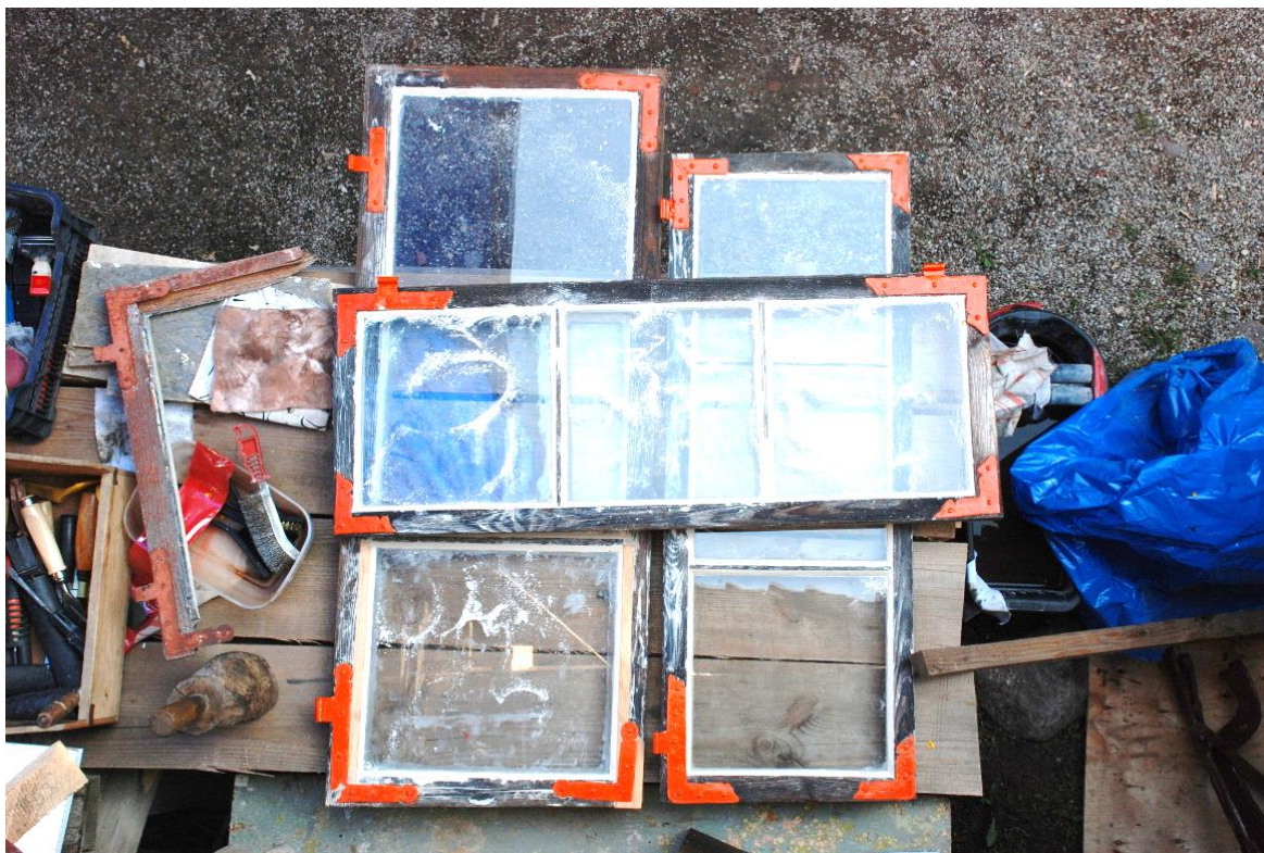
2. att. Logu vērtnes pēc remonta, gruntēšanas un iestiklošanas Aizputē, Atmodas ielā 9
