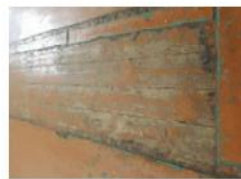
Esošā dēļu grīda sekundāri iesēģta ar inoleju, krāsota. Apgaismojuma, piesūcināma ar inoleju
