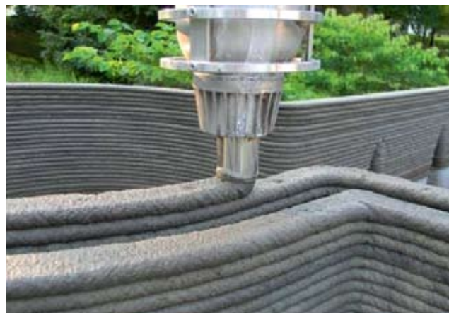
1. att. Printēšanas slāņi.
