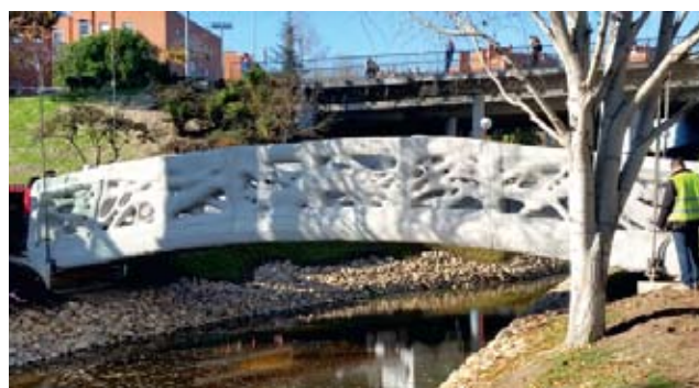
2. att. Alkobendas 3D printētais betona gājēju tilts.
