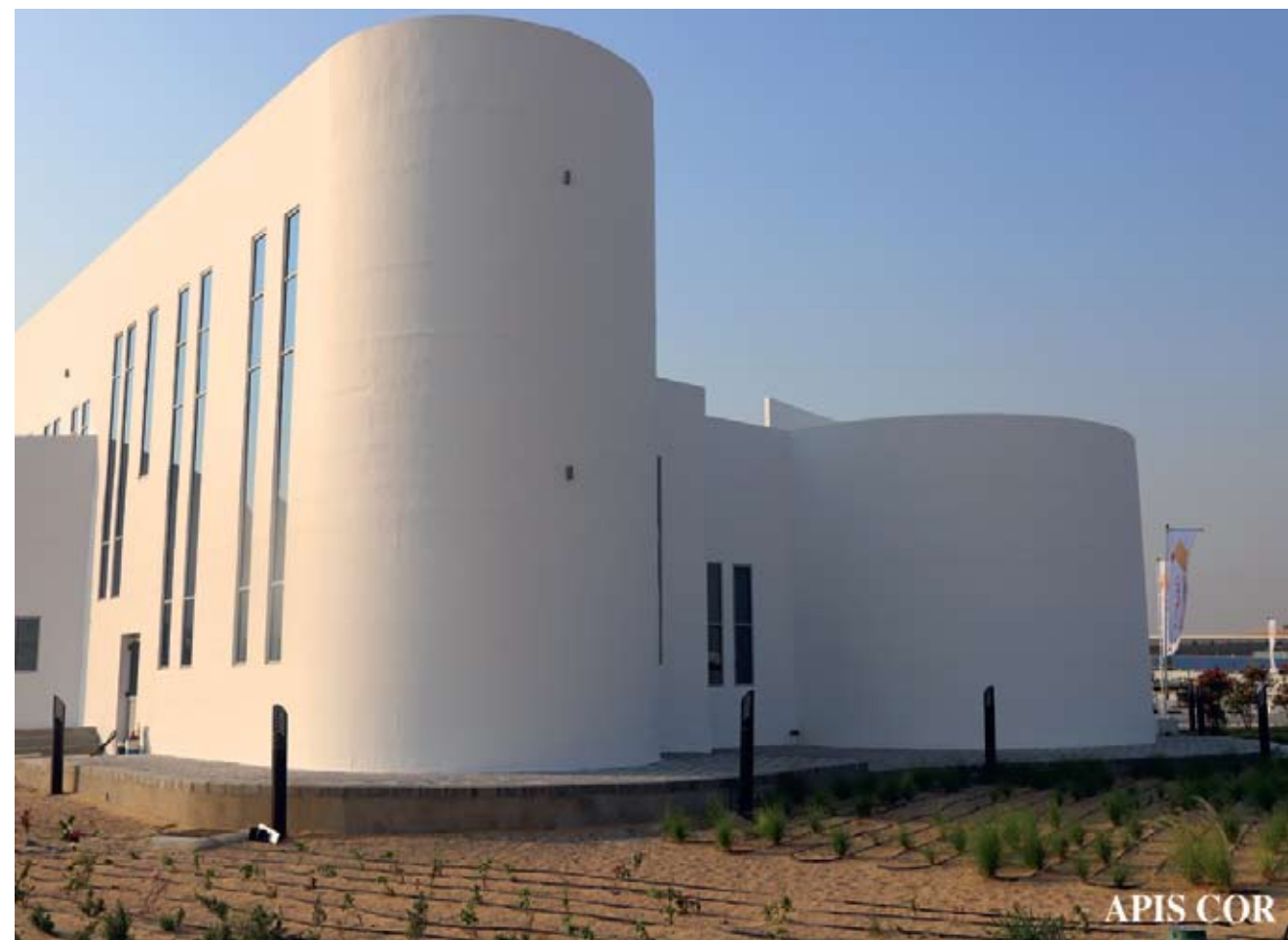
4. att. «Warsan» ēka – šobrīd pasaulē lielākā 3D printētā ēka.
