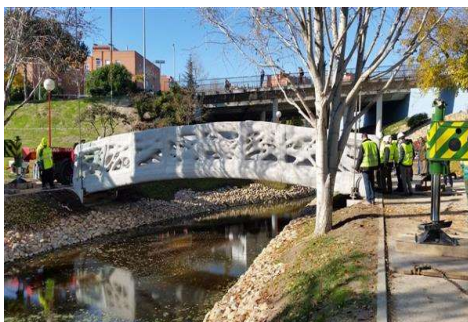
2.att. Alkobendas 3D printētais betona gājēju tilts
