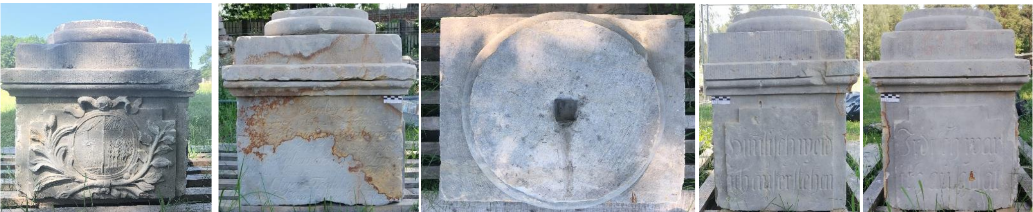
Pēc restaurācijas | After restoration
