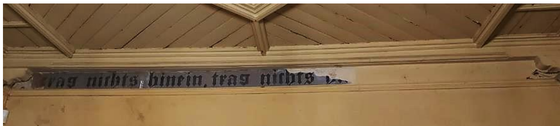
Pēc restaurācijas | After restoration
