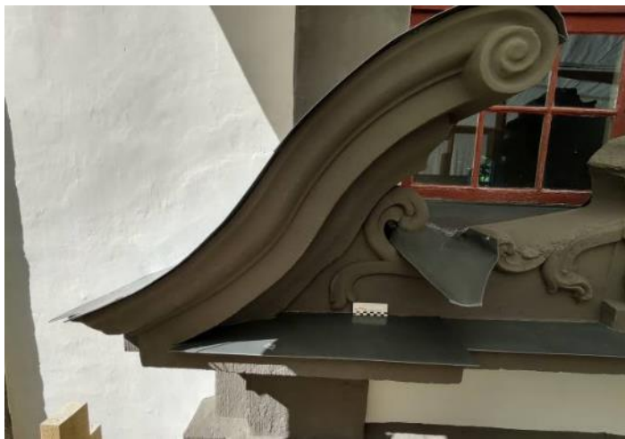
Pēc restaurācijas | After restoration
